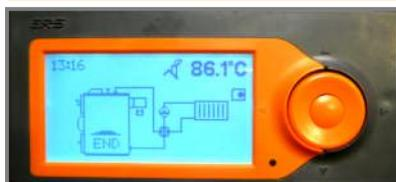
Lorsque la température de fumées descend sous la température mini programmée, la chaudière s'arrête en arrêtant le ventilateur.
