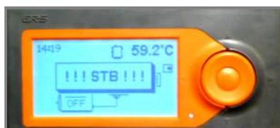
En cas de surchauffe de la chaudière (sup. à 95°C), la sécurité STB est enclenchée et coupe le ventilateur.
