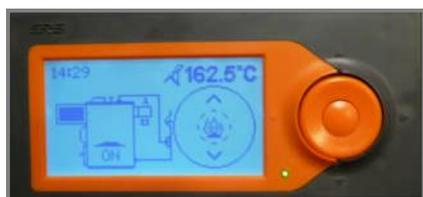
En appuyant sur la touche le ventilateur de combustion s'arrête. Il est possible d'ouvrir la porte de chargement, en ayant ouvert précédemment le clapet de tirage direct.
