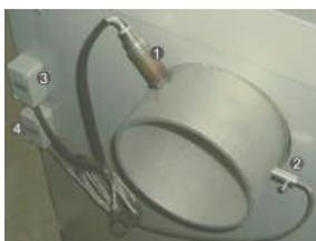
Pour un bon fonctionnement, la sonde de fumées (2) doit être nettoyée tous les mois en même temps que l'échangeur de chaleur.
