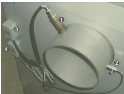
Pour un bon fonctionnement nettoyer régulièrement en enlevant la poussière de la sonde Lambda « 1 » et de la sonde de fumées « 2 », à l'aide d'un chiffon humide
